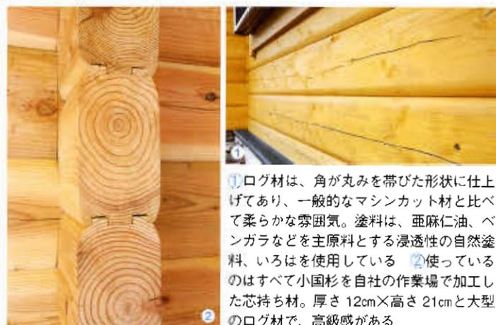
①ログ材は、角が丸みを帯びた形状に仕上げられており、一般的なマシンカット材と比べて柔らかな雰囲気。塗料は、亜麻仁油、ベンガラなどを主原料とする浸透性の自然塗料、いろはを使用している ②使っているのはすべて小国杉を自社の作業場で加工した芯持ち材。厚さ12cm×高さ21cmと大型のログ材で、高級感がある
