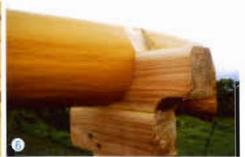
① マシンカットのログ材と磨き丸太の結合部分。大工の技が生かされている
